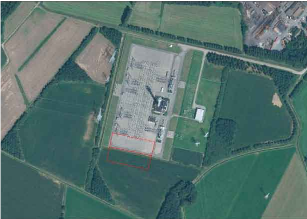
Abbildung 4.11 Die Hochspannungsstation Doetinchem mit den indikativ und in rot eingezeichneten Rechtecken, in denen die künftige Erweiterung gebaut werden soll
