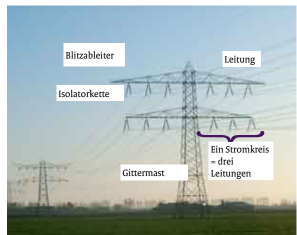
Beispiel für einen Gittermast mit 4 Stromkreisen
